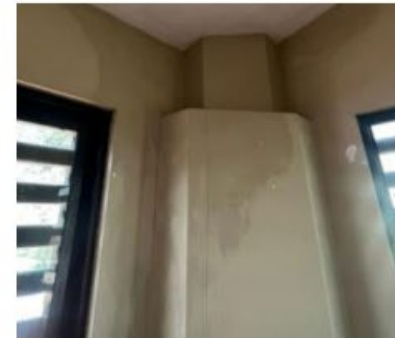
Imagen 1.5(Filtración chimenea)
